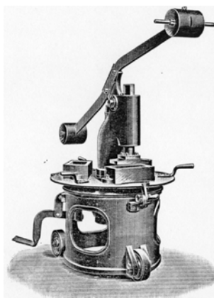
Figur 11. Efterpresse med drejebord fra firmaet E Fritsch (Bock 1901)
