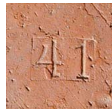
Figur 27. Formnummer presset ind i bagside af formstenen.
